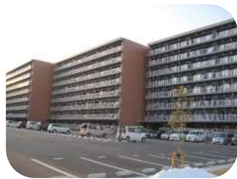
高台に建設された岩手県陸前高田市の災害公営住宅。（平成 29 年 1 月）
